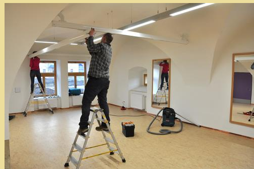
Instalace transportního zařízení ve cvičebním sále ve sv. Damiánovi
