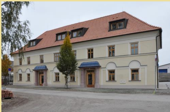
Budova fary po opravě
