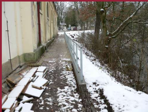
Průběh stavebních prací
